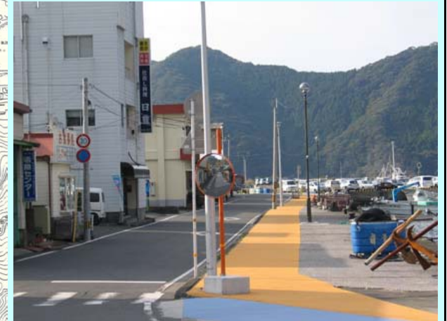
湾岸散策路(1000m) H18 歩道整備により歩行者の利便性向上
