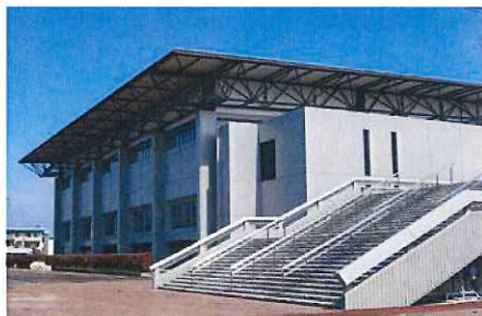
▲ 避難者の健康に配慮し整備。 長期収容避難に対応可能（総合体育館）
