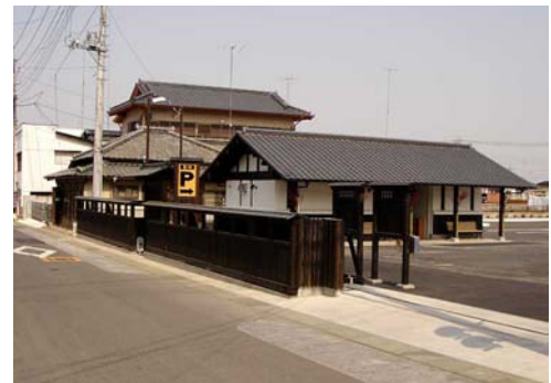
まちづくり交付金事業で整備した景観に配慮した駐車場および公衆トイレ
